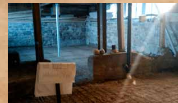
Tous les planchers ont du avoir une réfection importante dû à leur état très endommagé. Une dalle de béton a été coulé à grandeur au sous-sol.
