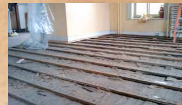
Tous les planchers ont du avoir une réfection importante dû à leur état très endommagé. Une dalle de béton a été coulé à grandeur au sous-sol.
